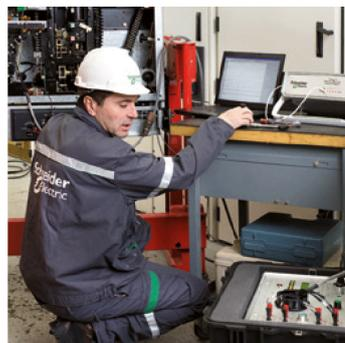
Le diagnostic régulier des performances électriques et cinématiques des disjoncteurs BT est effectué par le programme Advanced Manufacturer Maintenance. Cette solution apporte les avantages suivants à l'utilisateur :
